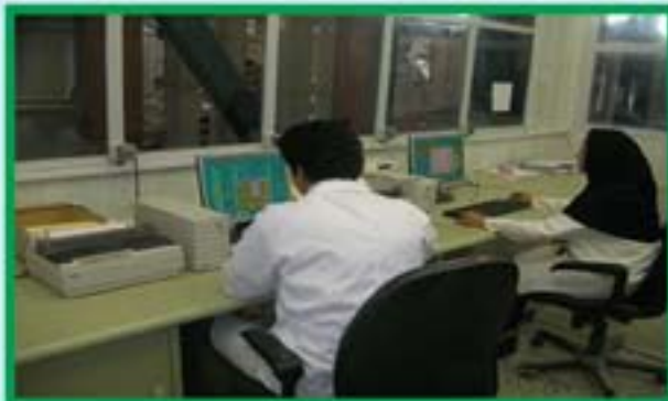
بهره گیری از سیستم کنترل P.L.C.
